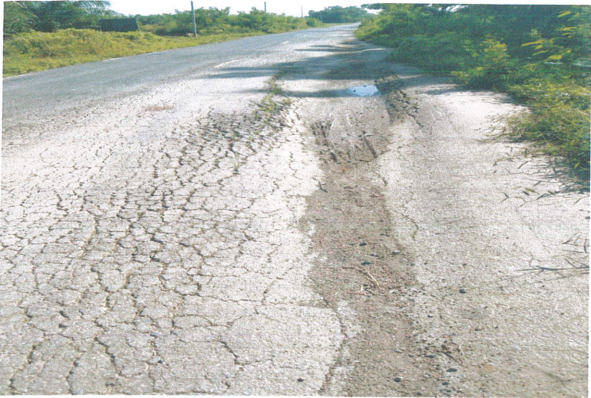
ภาพถ่ายสภาพสถานที่ดำเนินโครงการก่อสร้างถนนลาดยาง รหัสทางหลวงท้องถิ่น นศ.ถ. 131 - 07 สายหนองจระเข้ - เขตตำบลบ้านราม
