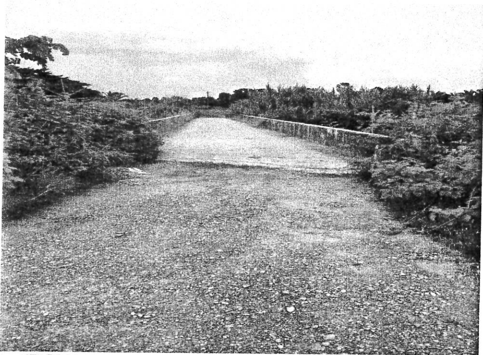
ภาพถ่ายคอสะพานข้ามชักน้ำสาย ๑ (บริเวณ บ้านนายเกษม ตำบลวังโรม)
