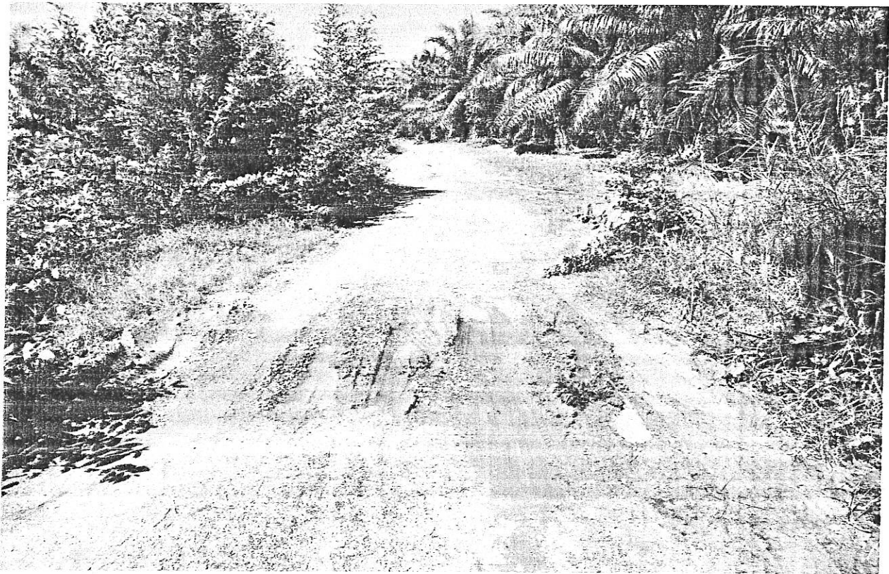
ภาพถ่ายสภาพปัจจุบัน (ถนนสายเขตตำบลบางนบ - เขตตำบลเสือหึง หมู่ที่ ๓,๖)
