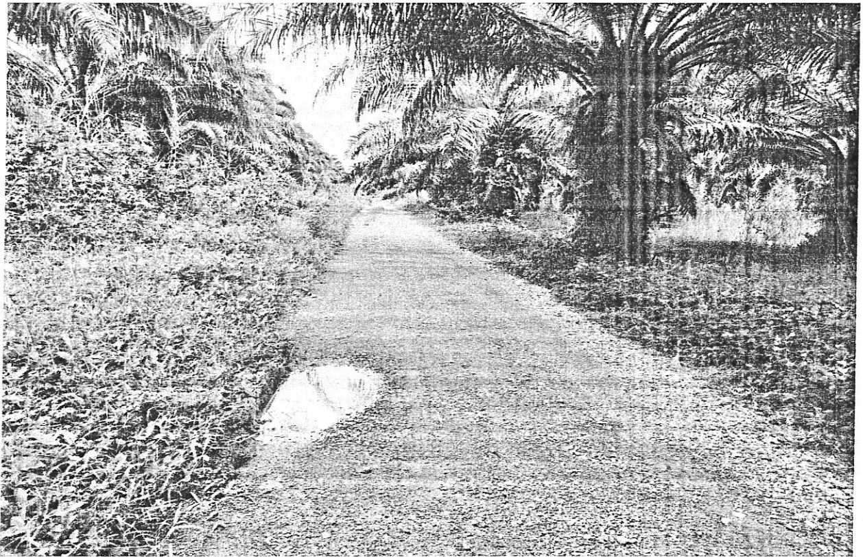
ภาพถ่ายสภาพปัจจุบัน (ถนนสายนายลาย หมู่ที่ ๓)
