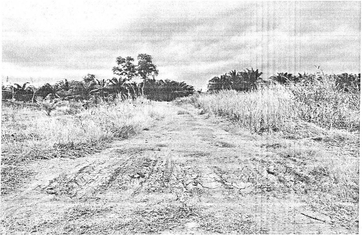
ภาพถ่ายสภาพปัจจุบัน (ถนนสายบ้านปลายนา ม.๑ - โคกวัด ม.๒ หมู่ที่ ๑)
