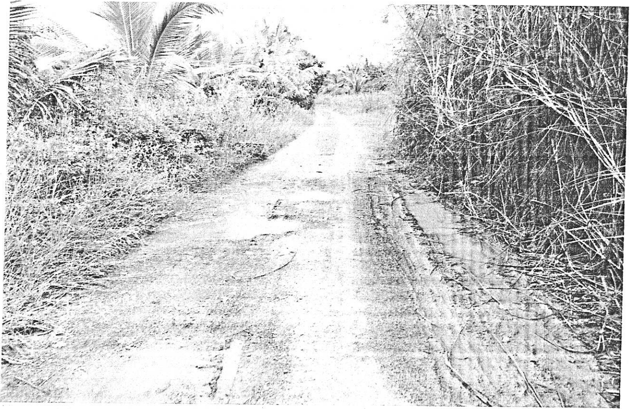
ภาพถ่ายสภาพปัจจุบัน (ถนนสายบ้านนายเกษม - คลองอาทิตย์ หมู่ที่ ๗)
