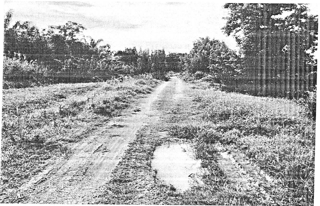
ภาพถ่ายสภาพปัจจุบัน (ถนนสายโรงพระจีน - คลองอาทิตย์ หมู่ที่ ๗)
