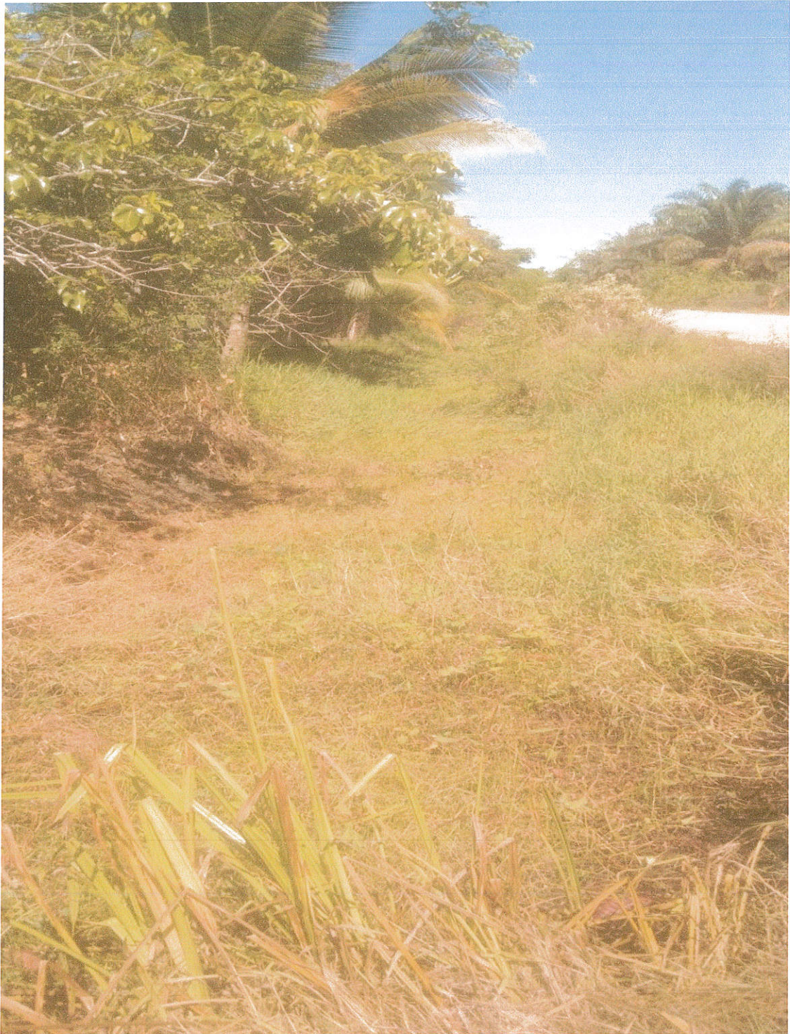
ภาพถ่ายสภาพปัจจุบัน (คู่งน้ำสายหนองทองจันทร์ ๒ หมู่ที่ ๘)
